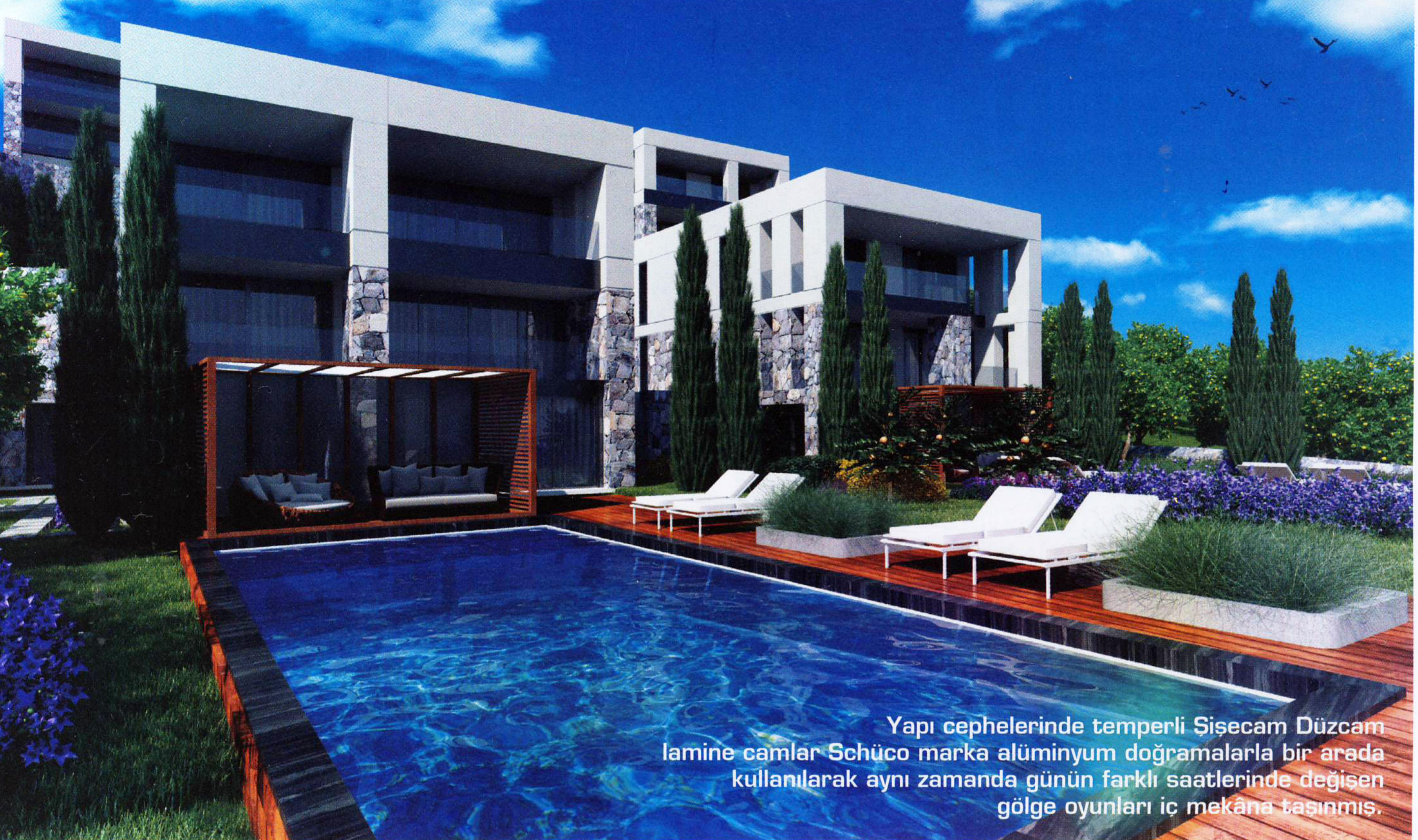
**Yapı cephelerinde temperli Şişecam Düzcam lamine camlar Schüco marka alüminyum doğramalarla bir arada kullanılarak aynı zamanda günün farklı saatlerinde değişen gölge oyunları iç mekâna taşınmış.**
